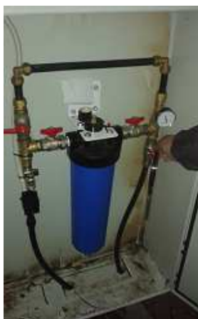
ΠΑΡΑΔΕΙΓΜΑ ΕΓΚΑΤΑΣΤΑΣΗΣ ΣΑΚΟΦΙΛΤΡΟΥ
