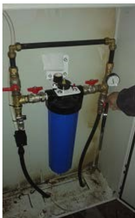
ΠΑΡΑΔΕΙΓΜΑ ΕΓΚΑΤΑΣΤΑΣΗΣ ΣΑΚΟΦΙΛΤΡΟΥ
